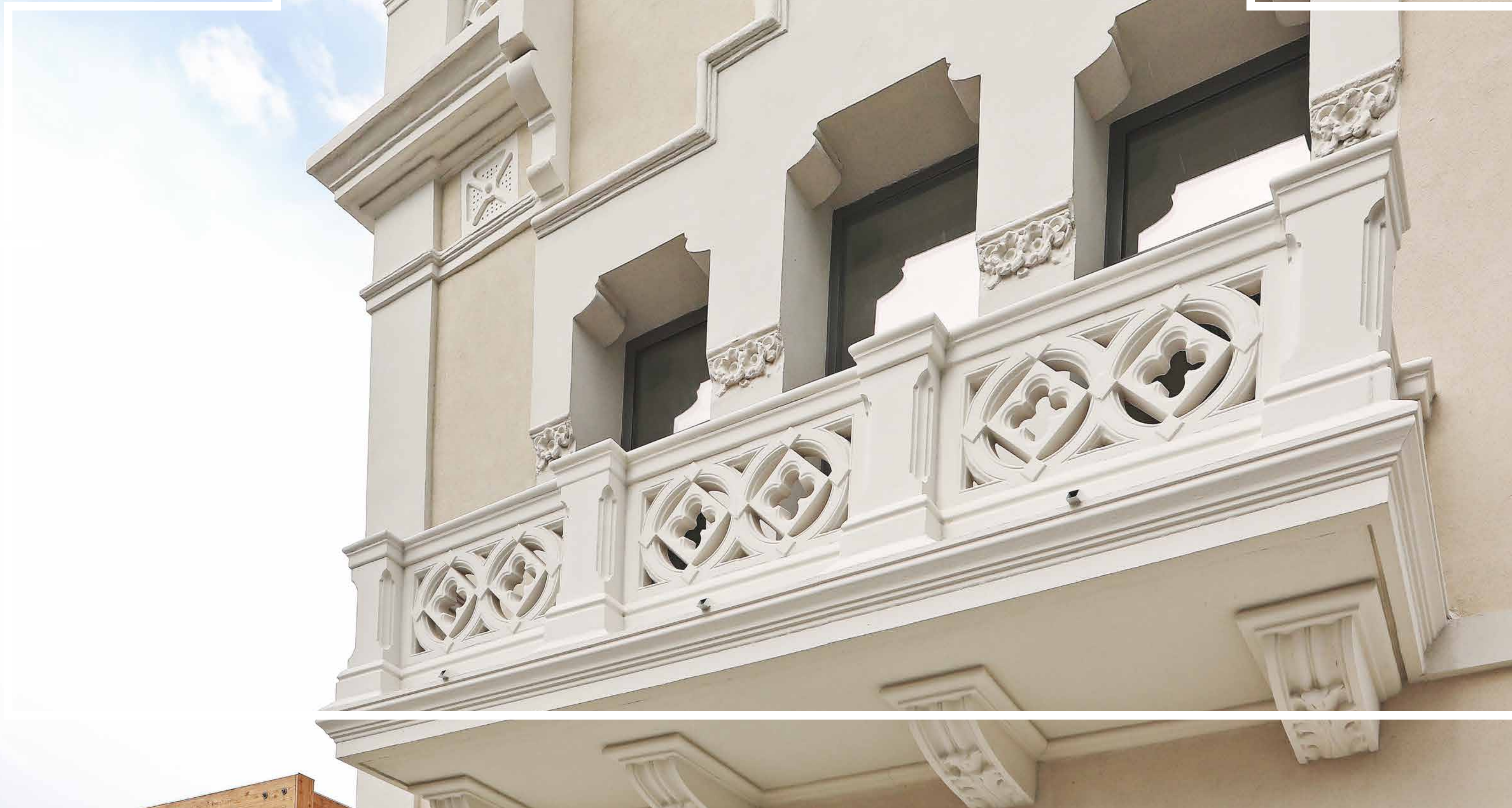
FAÇANA SALA ANEXA
